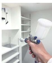
専用スプレーガンで、水分を飛ばしながら噴霧します。
